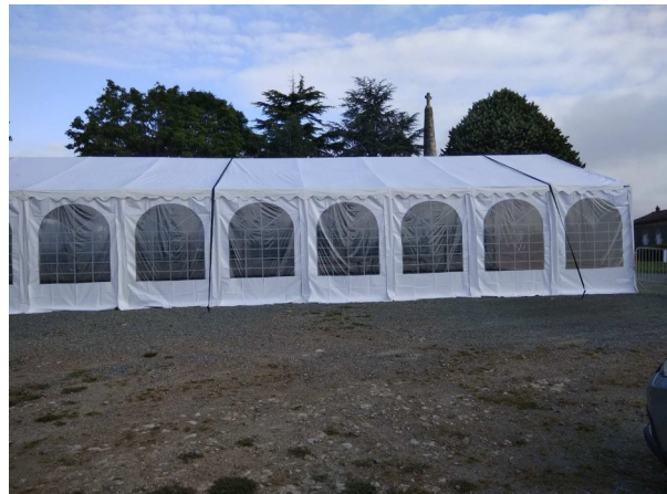
Installation d'un nouveau Tivoli sur l'espace Francis Gonnord
